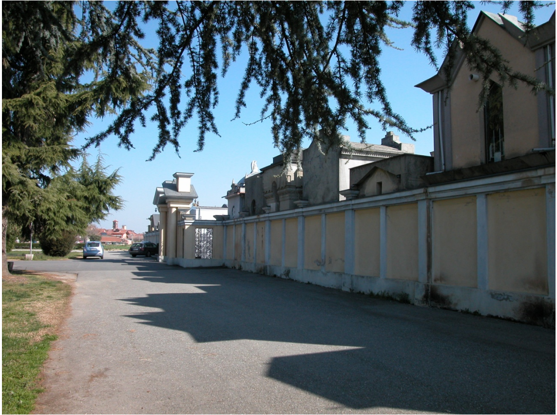
Muro a ovest
