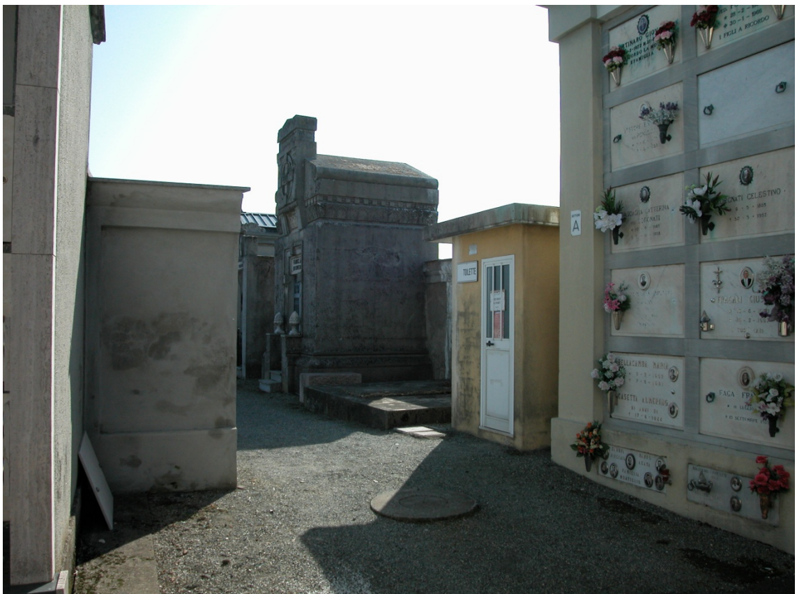
Vista sul loculario,, settore "C" e passaggio al campo "A"
